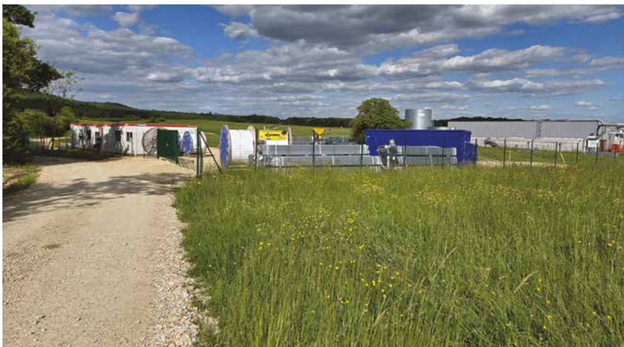
▲ ZA de la Croisette, démarrage du chantier de la centrale solaire
