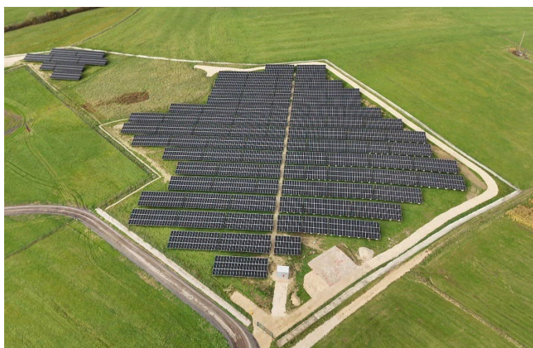
Centrale solaire de Vittel – Crédit photo Urbasolar
