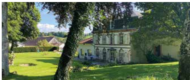
Meublé touristique à Monthureux-le-Sec (2021) : création chambre d'hôtes PMR, piscine extérieure et remplacement de l'escalier
