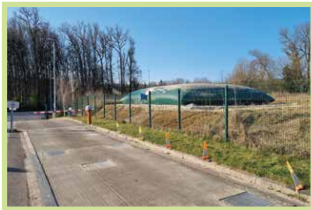
▲ Installation d'une réserve incendie
